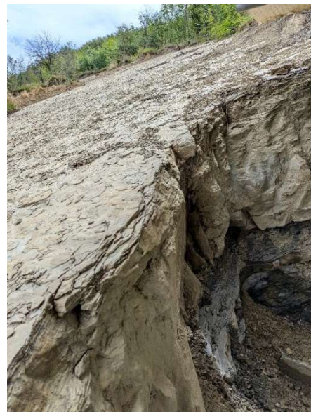
Fig.5 L'inizio della frana in roccia con il dettaglio della stratigrafia come visto dallo sbancamento presso la Tordicella (foto L. Ravagli)
