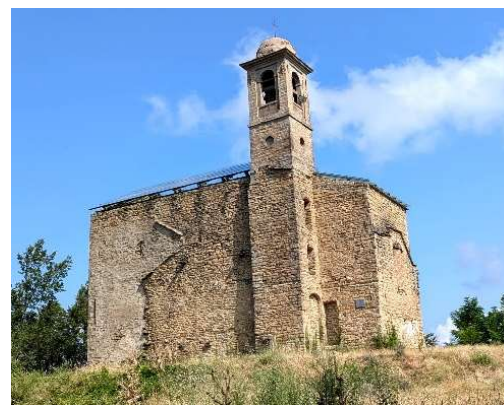
Fig.20 Valmaggione oggi con le tracce murarie dell'abbattimento della canonica (foto L. Ravagli)
